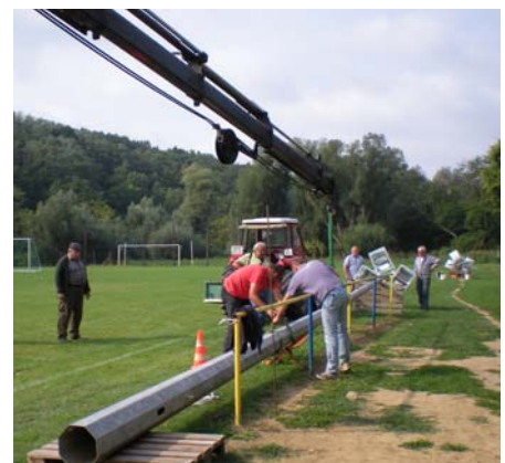
Beim Aufstellen der Flutlichtanlage
